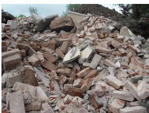
Abbruch- und Ladearbeiten
