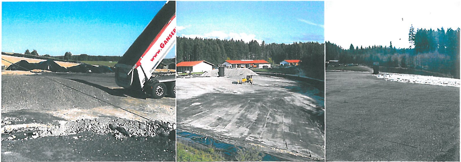
Erste Schlackeanlieferung. Einbau der Ausgleichsschicht
