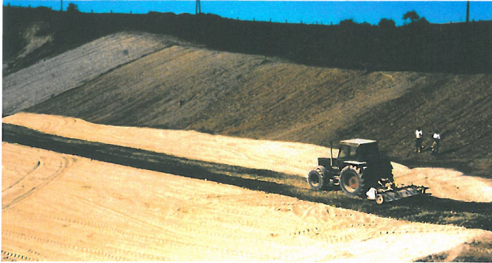
Einfräsen von Tonmehl (Montigel F) im BA I durch Fa. Swietelsky
