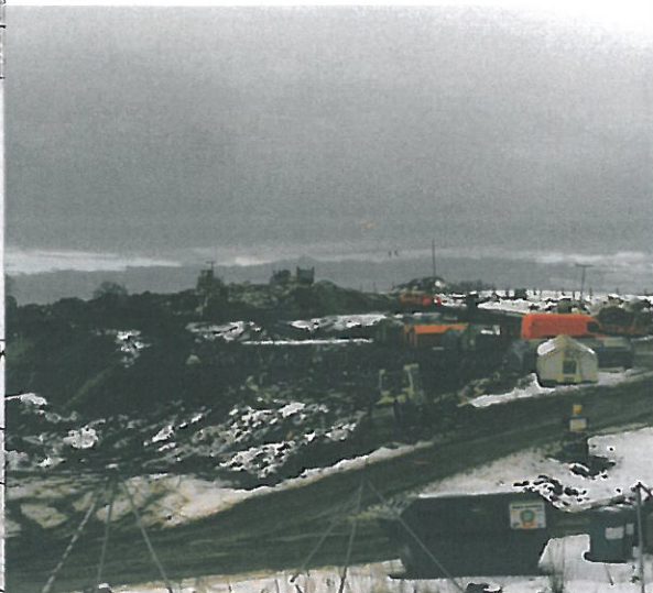
Verfüllbetrieb Januar 1988, Blick auf BA I und II
