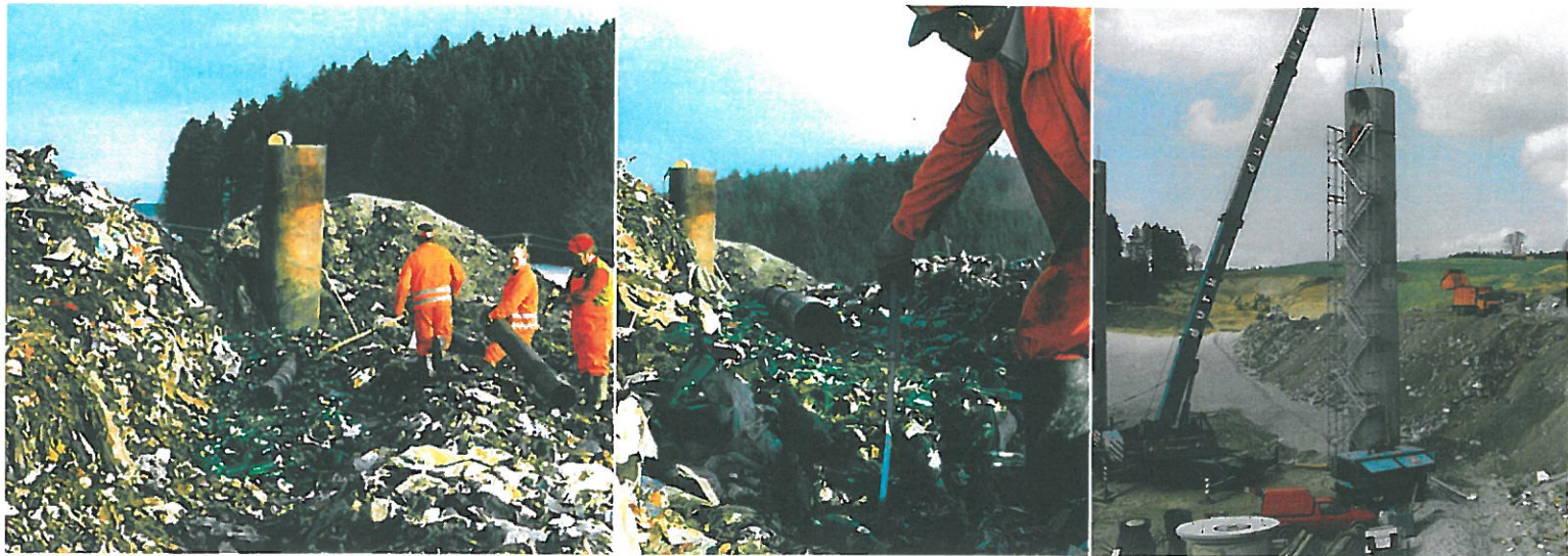
Bau von Gasdrainagen durch Landkreismitarbeiter
