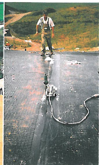
Schweißen einer Überlappnaht der Kunststoffdichtungsbahnen
