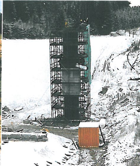
Errichtung Sickerwasserpumpschacht BA III a im Dez 1994 durch die Fa. ADT
