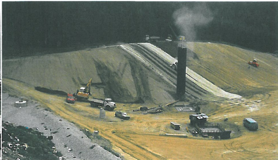
Errichtung der Basisabdichtung des BA III durch die Fa. Swietelsky mit Sickerwasserpumpschacht
