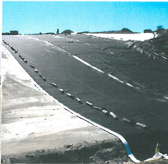
Aufgebrachte Kunststoffichtungsbahn (KDB)
