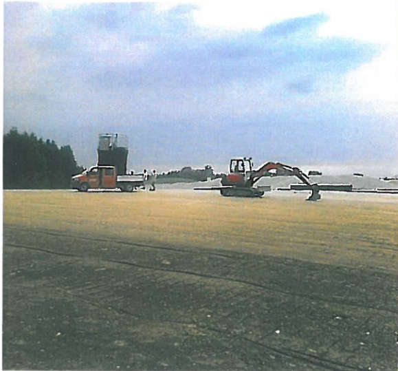
Fertige mineralische Abdichtung
