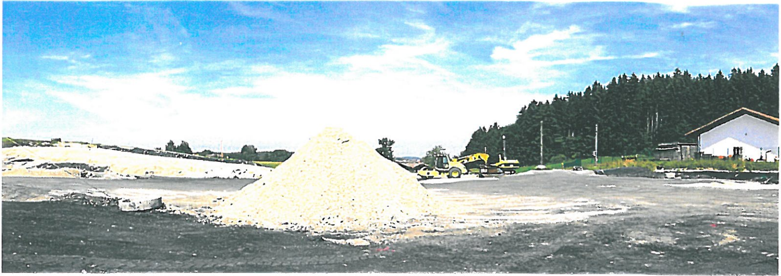
Fertiggestellte Trag- und Ausgleichsschicht Müllplanie aus Schlacke
