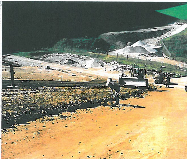
Einbau der mineralischen Oberflächenabdichtung im BA III durch Fa. Strabag
