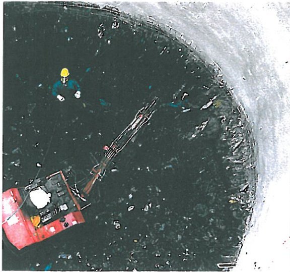
Sanierung Sickerwasserleitungen und -schächte Müllaushub mit Minibagger, Personal durch Atemschutz geschützt
